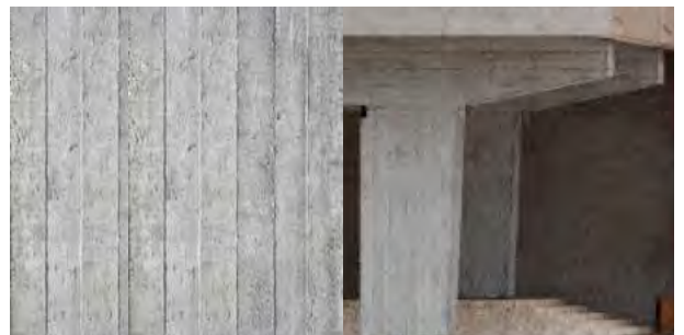
Esamos betoninės laikančios konstrukcijos lietos iš lentų suformuotme klotinyje
